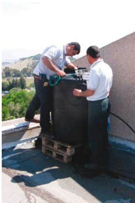
התקנת מיכל על גג הבניין
